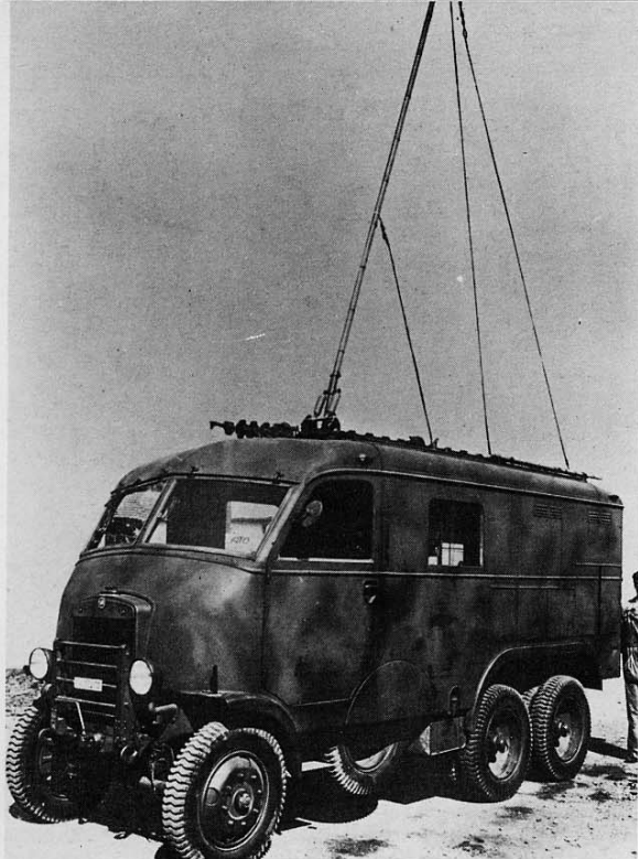
UNA DELLE TANTE MODIFICHE APPORTATE AL DOVUNQUE 35. SI TRATTA IN QUESTO CASO DELLA VERSIONE PER RADIO TRASMISSIONI CAMPALI. MATRICOLA R.A. 30270.
