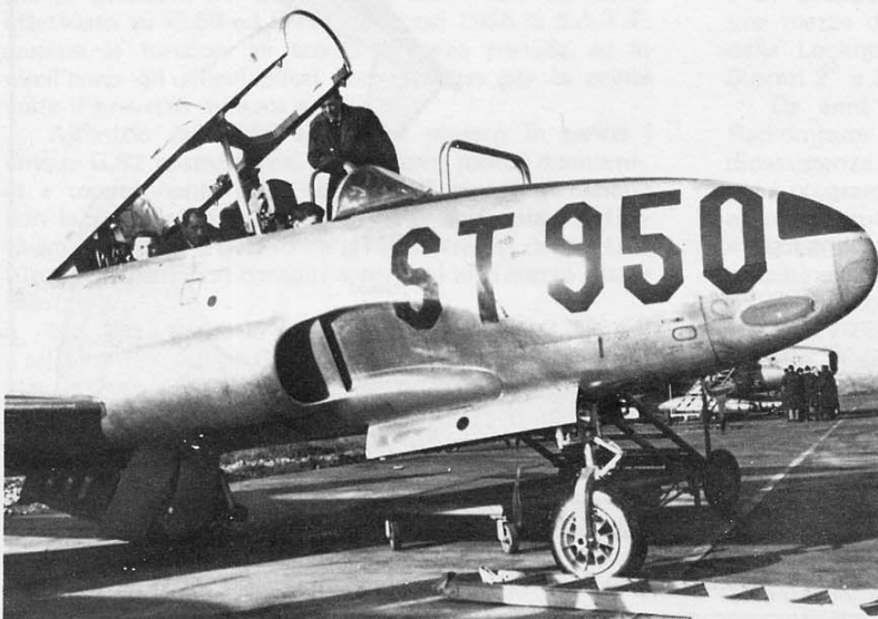
Qui sopra un T-33 che porta ancora la sigla ST, ma che ha avuto il serial number USAF sulla deriva sostituito dalla M.M. 55-3034 sotto l'impennaggio orizzontale. Questi particolari datano la foto tra gli anni 59-61. (Foto A.M.I.)
