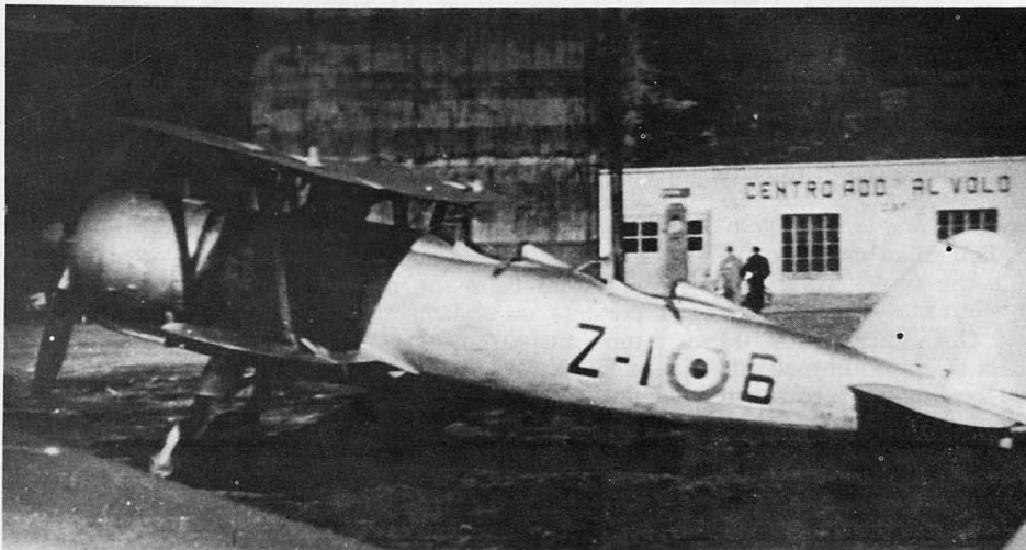
Un'altra veduta dello stesso velivolo, ma purtroppo la documentazione fotografica su questa variante del Falco è estremamente scarsa. Notare l'assenza della carenatura sul carrello. La sigla Z-106 indica l'appartenenza del velivolo alla 1ª ZAT, cioè la Zona Aerea Territoriale del Nord Italia. (Foto I. De Marchi, via G. Garelli)
