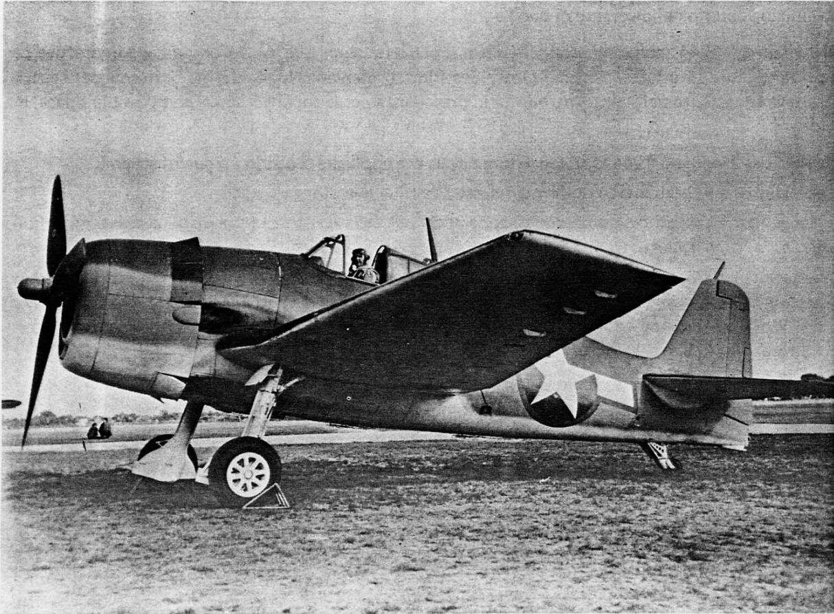
Grumman F6F-3 “Hellcat” pronto per la consegna verso l’inizio del 1943. Lo schema mimetico è quello classico a tre toni come descritto nell’articolo. Probabilmente nella riproduzione non apparirà evidente che la parte fissa della superficie inferiore dell’ala è bianca, mentre quella mobile è “Intermediate Blue” (Foto Grumman tramite Pini).
